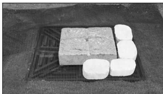
14. Pour la Bubbling Fountain Stone (58081), finissez de placer les pavés supplémentaires pour agrandir la surface de la fontaine et remplir au besoin les espaces vides entre les pavés.
