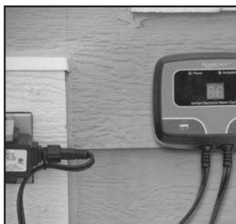
Fig. 1 Installez le boîtier de commande du clarificateur lonGen<sup>MC</sup> à l'endroit souhaité.
